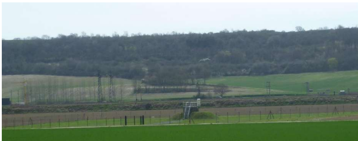
Captage n°0156-6X-0204 et périmètre de protection immédiat
