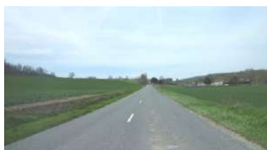
RD 15 en entrée de ville
