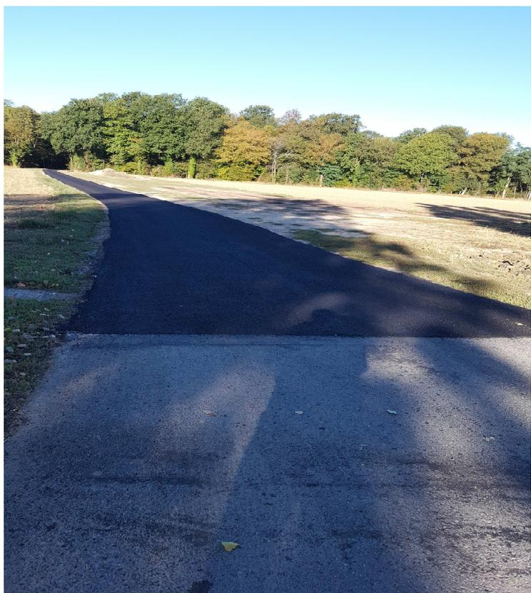
Les travaux de finitions se sont déroulés les 25 et 26 septembre 2018 par la mise en place d'un tapis bitumeux avec de la fibre végétale pour une meilleure résistance au trafic important.
