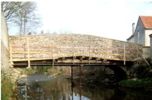
Le pont Auger se termine. Il reste à poser les pavés sur le cheminement après l'installation des différentes canalisations et la finition des joints. L'aménagement de la place avec des emplacements de stationnement terminera cet ensemble.
