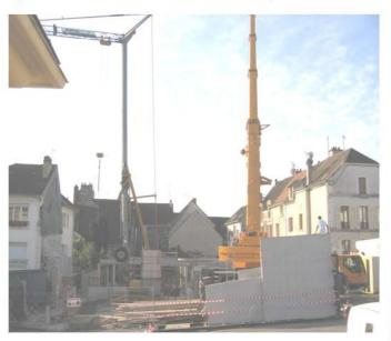
Actuellement, les poutres en béton de la dalle du 1er étage sont installées et la pose du « pré-mur » en béton se termine.
