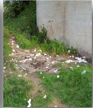
Sous le pont
